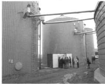
(a) 威塞尔市沼气设施的罐体
