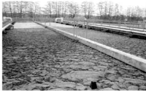
(a) 赛维塔尔污水厂的膨胀污泥
