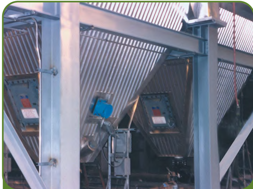
Syntron® V-85电磁式仓壁振动器在静电沉淀器收集料斗上保持粉尘微颗粒的流动
