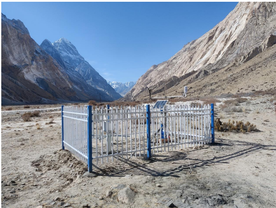
西天山隧道出口-温宿方向-气象监测站
