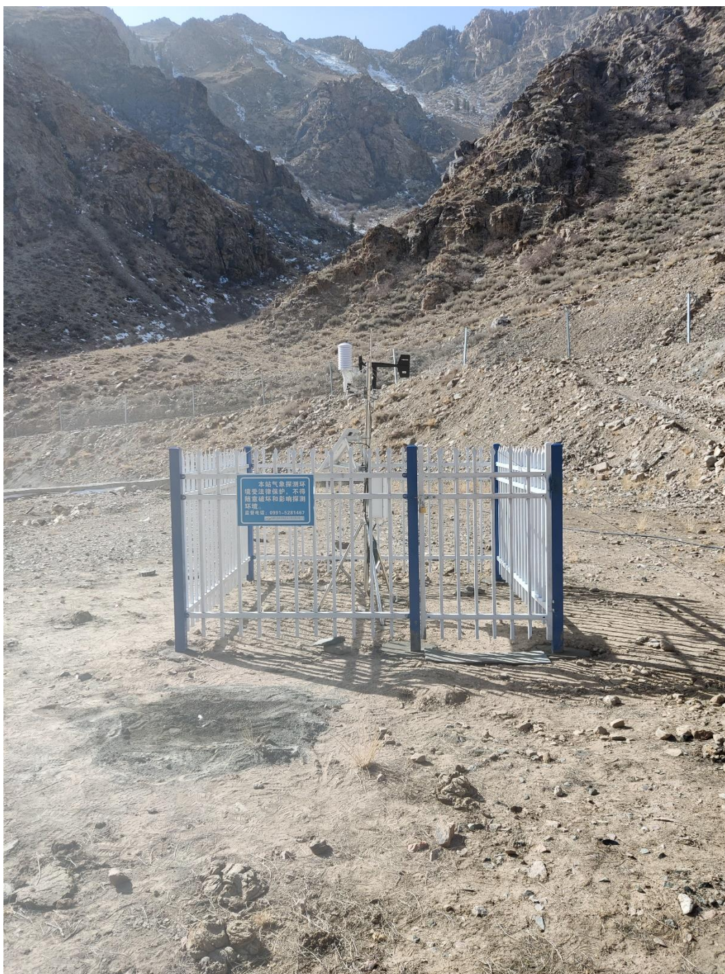
东天山隧道出口-哈密方向-气象监测站
