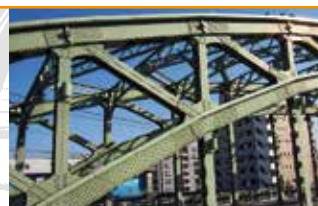
在特殊环境中对防腐保护性涂层进行测量
