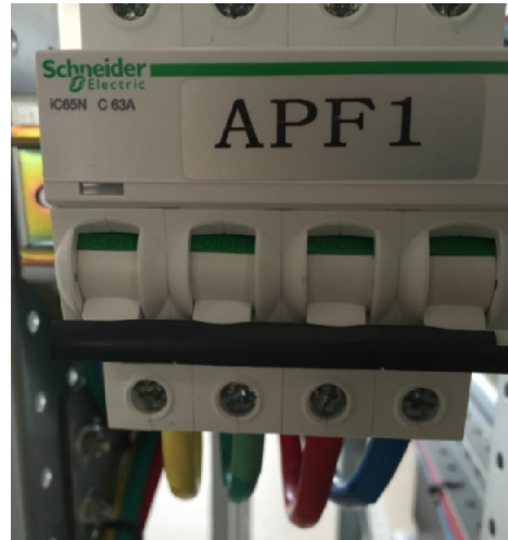
图 2-16 微型断路器接线示意
