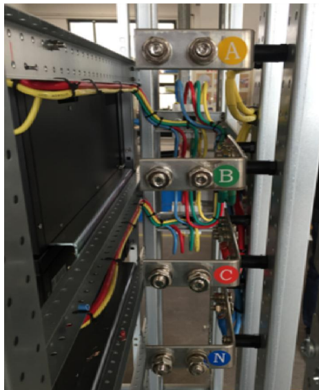
图 2-17 汇流排接线示意
