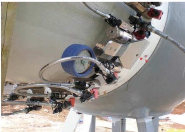
转子叶片螺栓安装
