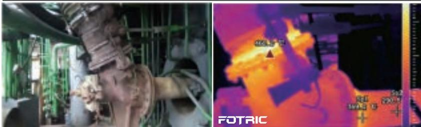
热风炉拱顶耐材温度监测
