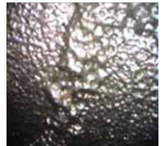
IPLEX TX显示器上的图像
