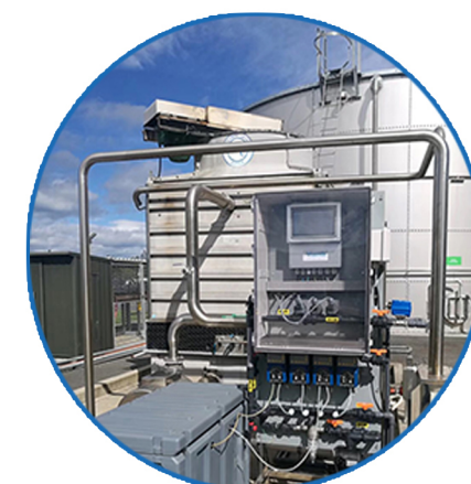
国外某工厂冷却水加药系统
