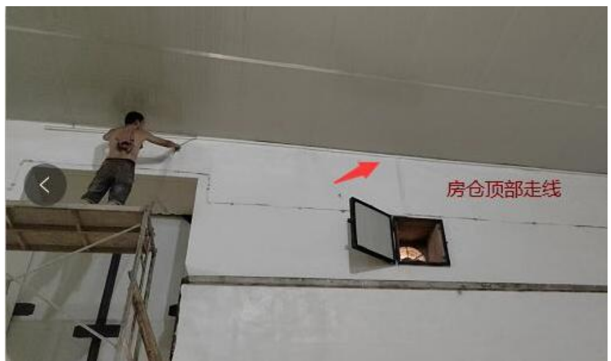
房仓无粮食状态现场安装
