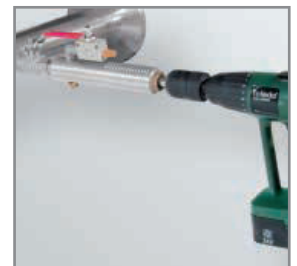
在有压力情况下使用 CS 钻孔装置钻孔
