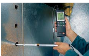
空调通风系统调试
