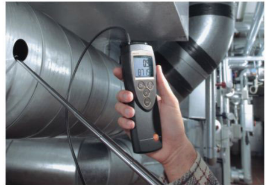
testo 425, 检测排风口的风量
