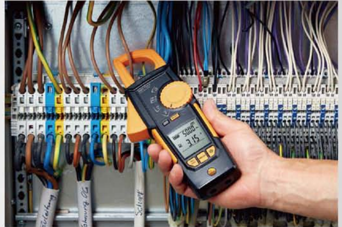
测量开关柜电流
