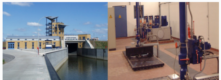
SONOCONTROL用于在德国中部地区河道闸门位置控制
