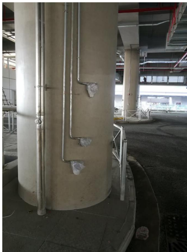
图为港珠澳大桥，深国安高精度气体检测仪安装现场。
