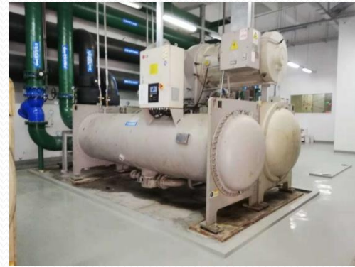
安装水冷离心式冷水机组工程
