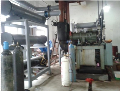
改造水冷冷水机组系统
