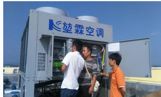
安装风冷螺杆热泵机组工程
