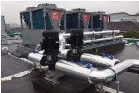
安装空气能热泵工程
