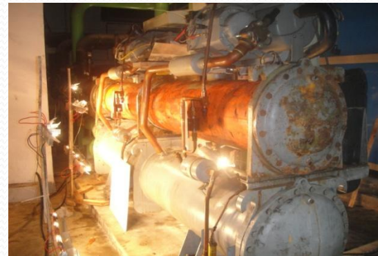
维修水冷螺杆式冷水机组
