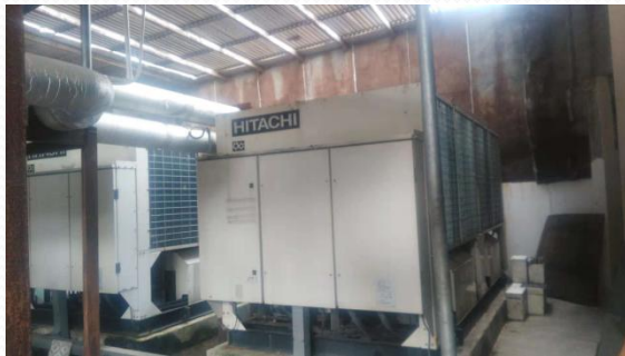
安装风冷热泵机组工程
