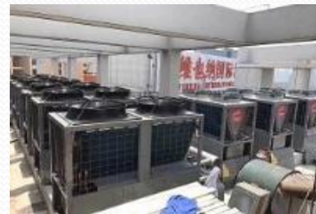
安装直热式空气能热泵工程
