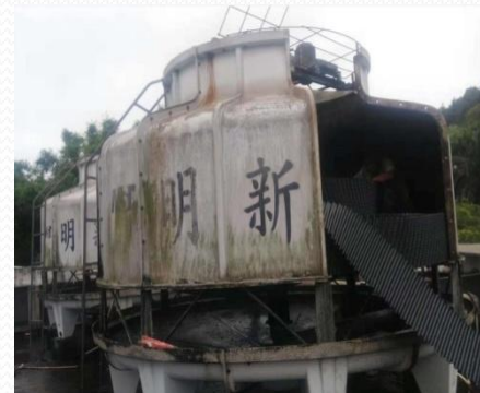
维保冷却塔设备
