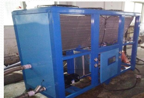
安装工业冷水机工程
