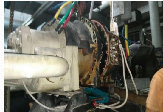
维修水冷冷水机组压缩机
