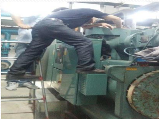
维修水冷螺杆式冷水机组
