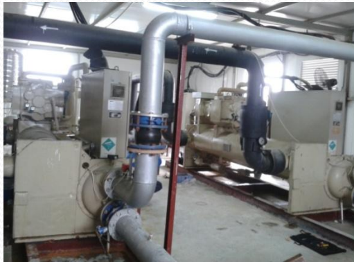
安装水冷螺杆式冷水机组工程
