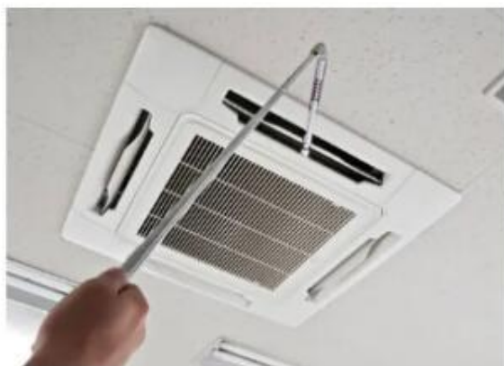
空调出风口测试
