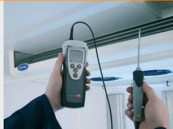
检测空调系统的温度
